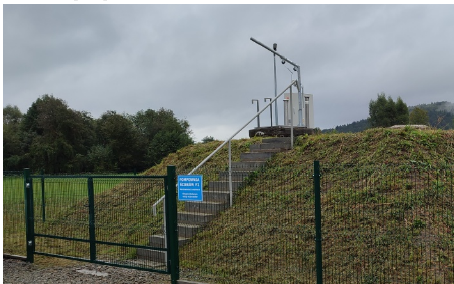
Nowe odcinki kanalizacji w Marcinkowicach i Dąbrowej
