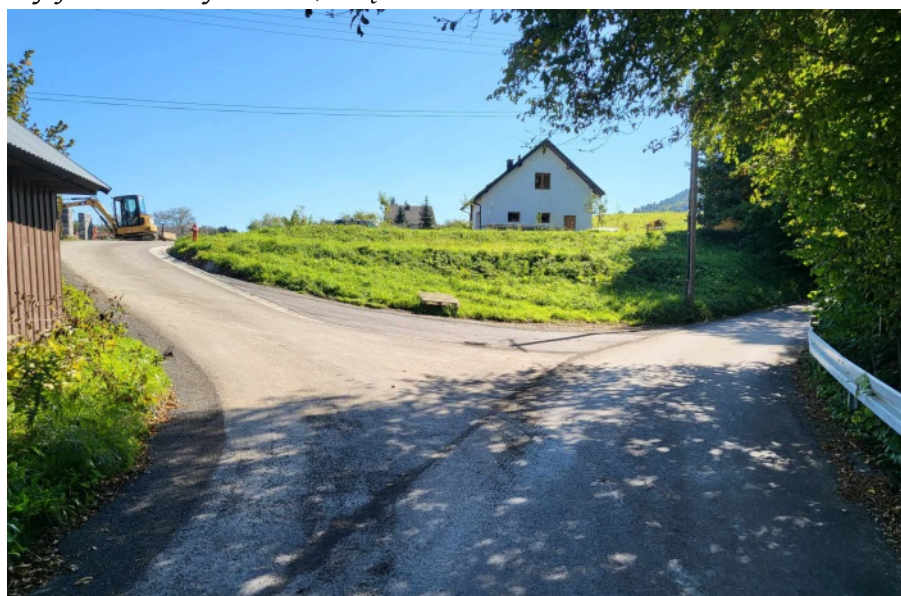
Remont kolejnych 8 dróg gminnych
