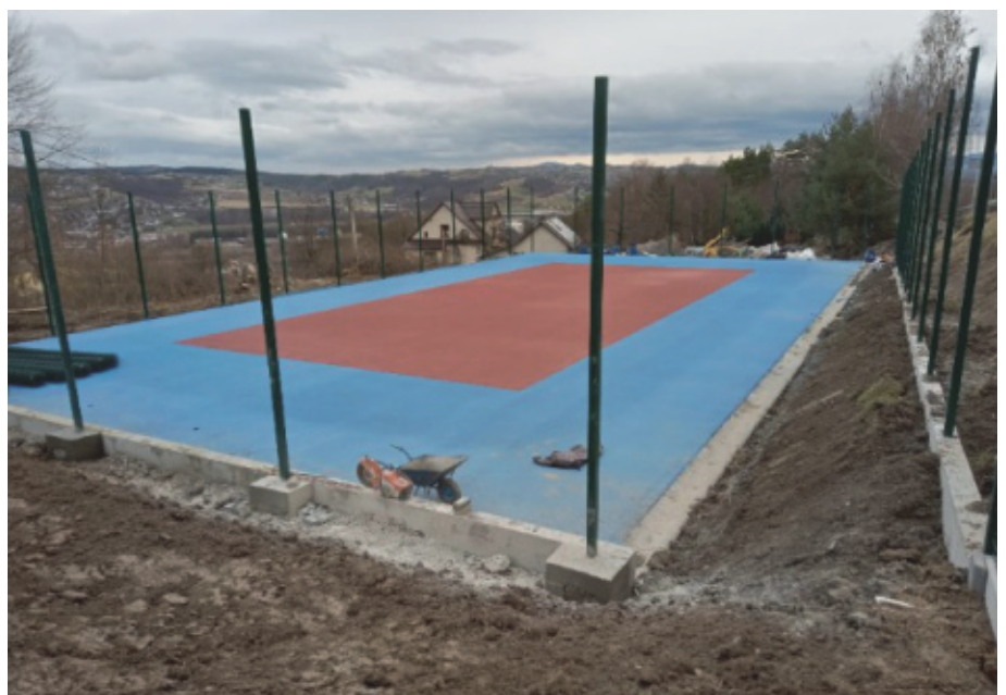
Remont boiska w Rdziostowie
