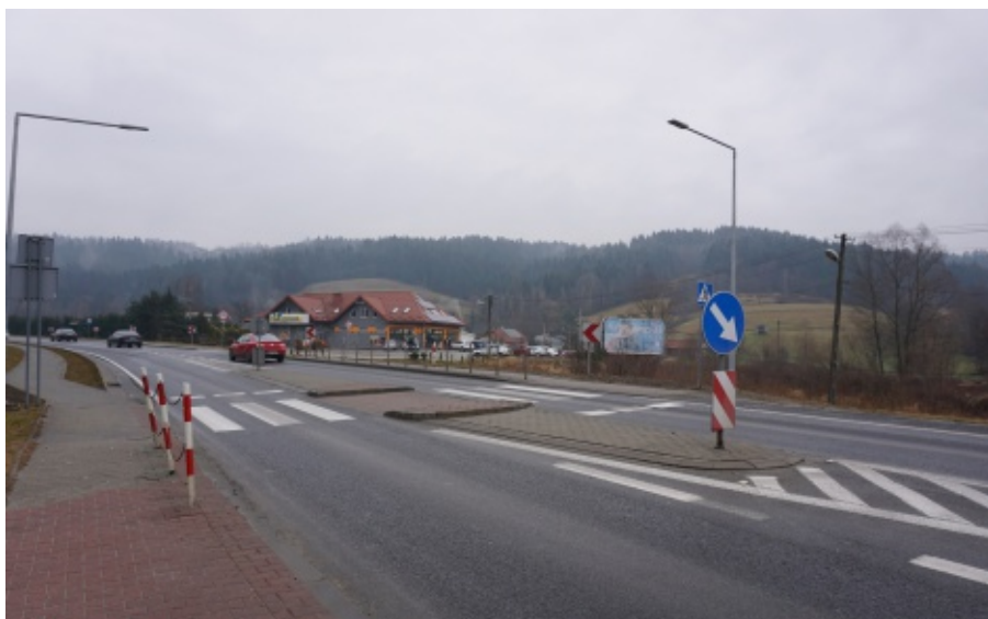
Kolejne doświetlone przejścia dla pieszych
