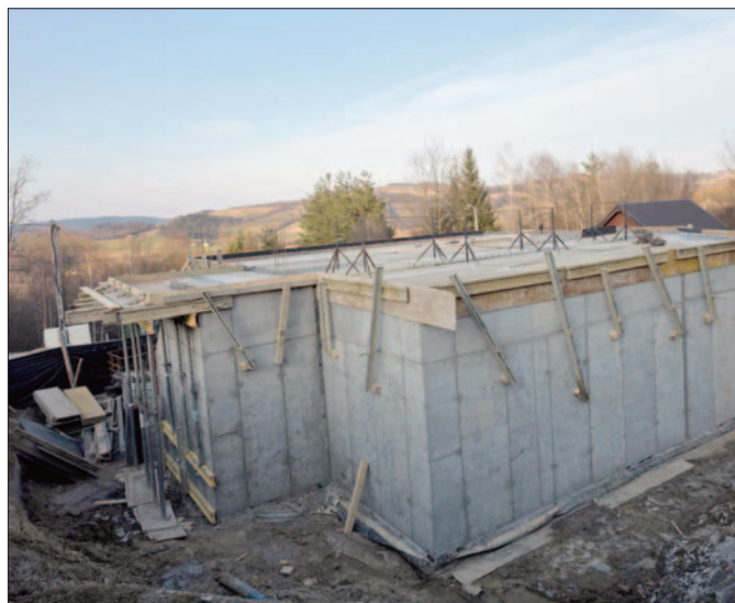
Trwa budowa świetlicy w Woli Kurowskiej...
