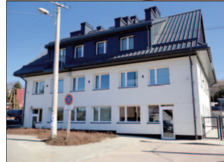
Budynek wielofunkcyjny w Wielogłowach przed i po termomodernizacji
