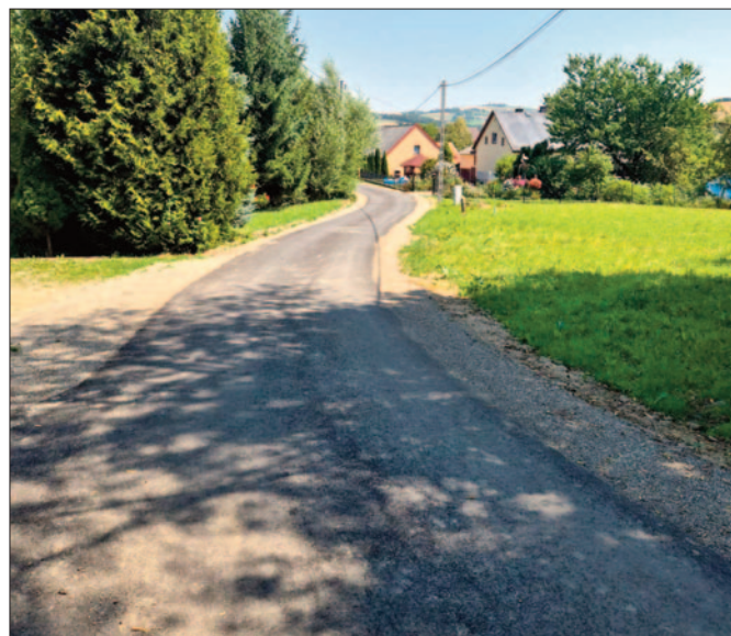
Wyremontowana droga Czaśniki w Woli Kurowskiej. Koszt inwestycji – 181 957,34 zł
