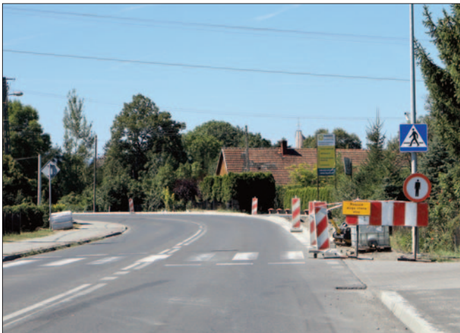
Budowa chodnika w Świniarsku. Inwestycję realizuje Powiatowy Zarząd Dróg w Nowym Sączu przy współfinansowaniu gminy Chętniec, która zapłaciła za projekt – 71 340 zł i przekazała dotację 385 tys. zł na to zadanie
