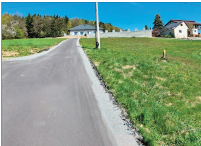
Wyremontowana droga w Naćsiszowej. Koszt inwestycji – 143 047,17 zł
