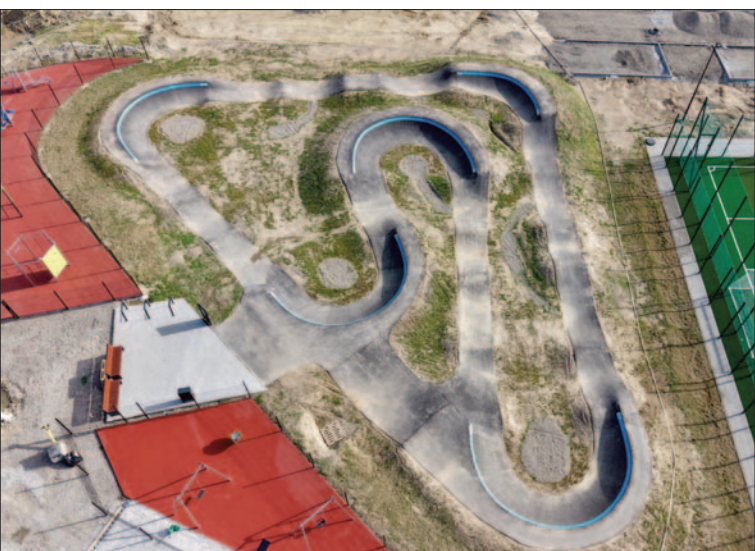
Pumpmtrack w Wielopolu już został oddany do użytku. Budowa toru rowerowego wraz z elementami małej architektury kosztowała 465 555,00 zł
