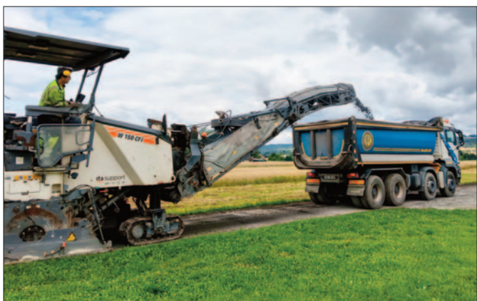
Remont ul. Świerkowej w Małej Wsi. Wartość inwestycji – 607 190,18 zł
