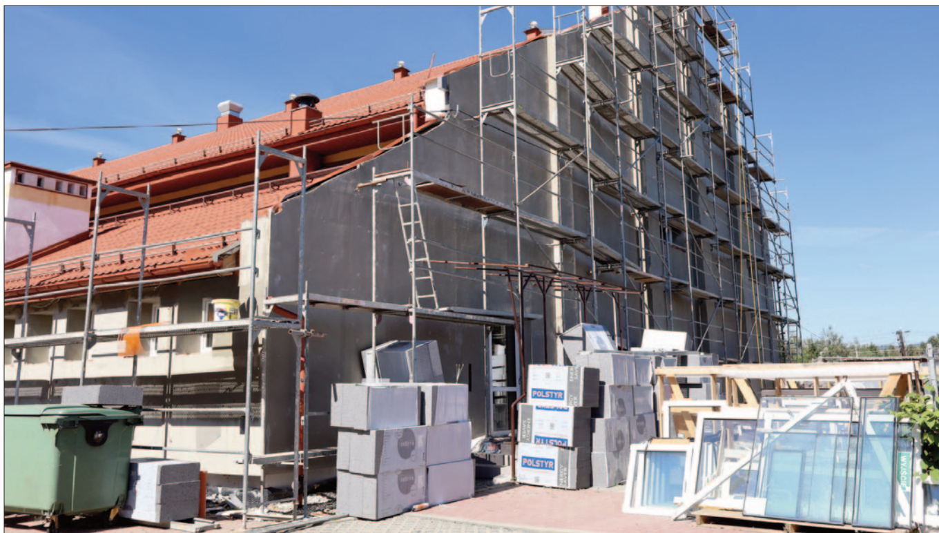
Trwa termomodernizacja sali gimnastycznej w Świniarsku
