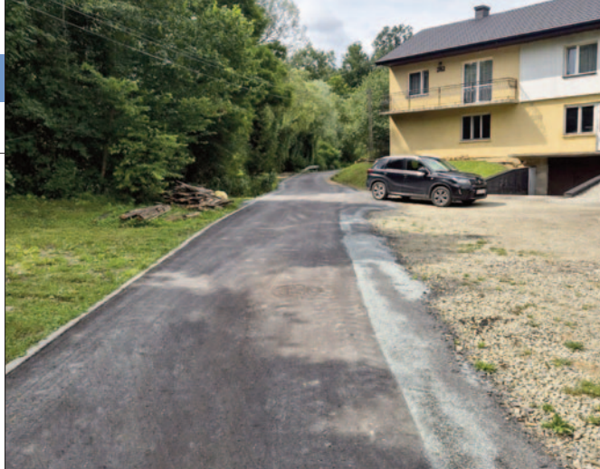
Wyremontowana droga do przepompowni w Kłęczanach. Koszt inwestycji – 119 282,94 zł
