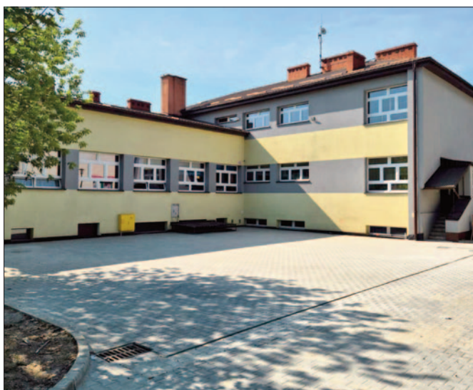
Nie tylko dworek w Kłęczanach przechodzi metamorfozę [str. 20]. Zmienia się również otoczenie wokół niego wraz z drogą dojazdową. W ramach realizowanego przez gminę zadania wykonano również parkingi przy znajdującym się w pobliżu budynku szkoły. Koszt dodatkowych robót wyniósł 177 955, 59 zł
