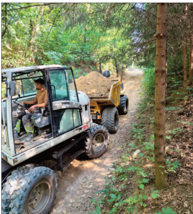
Budowa sieci kanalizacji deszczowej stanowiąca odwodnienie drogi wewnętrznej oraz remont odcinka drogi wewnętrznej w Kurowie. Koszt inwestycji – 224 365,28 zł
