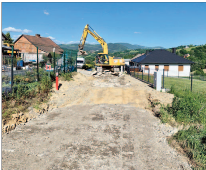
Remont drogi „Bierńkówka” w Wielogłowach. Koszt inwestycji – 597 548,28 zł
