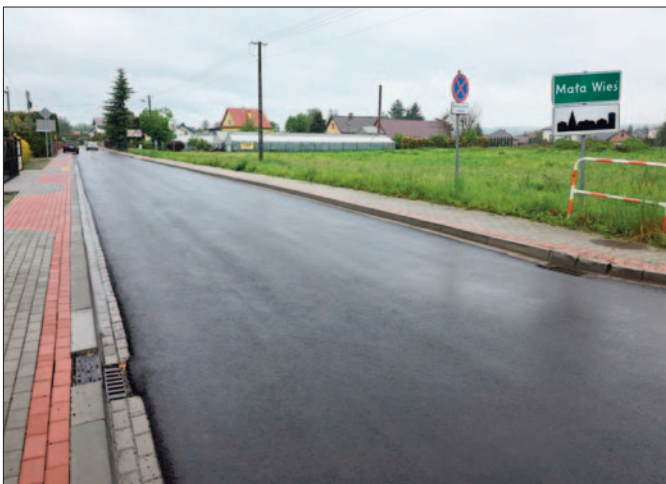
Wyremontowana ul. Starowiejska w Małej Wsi. Koszt inwestycji – 397 565,22 zł
