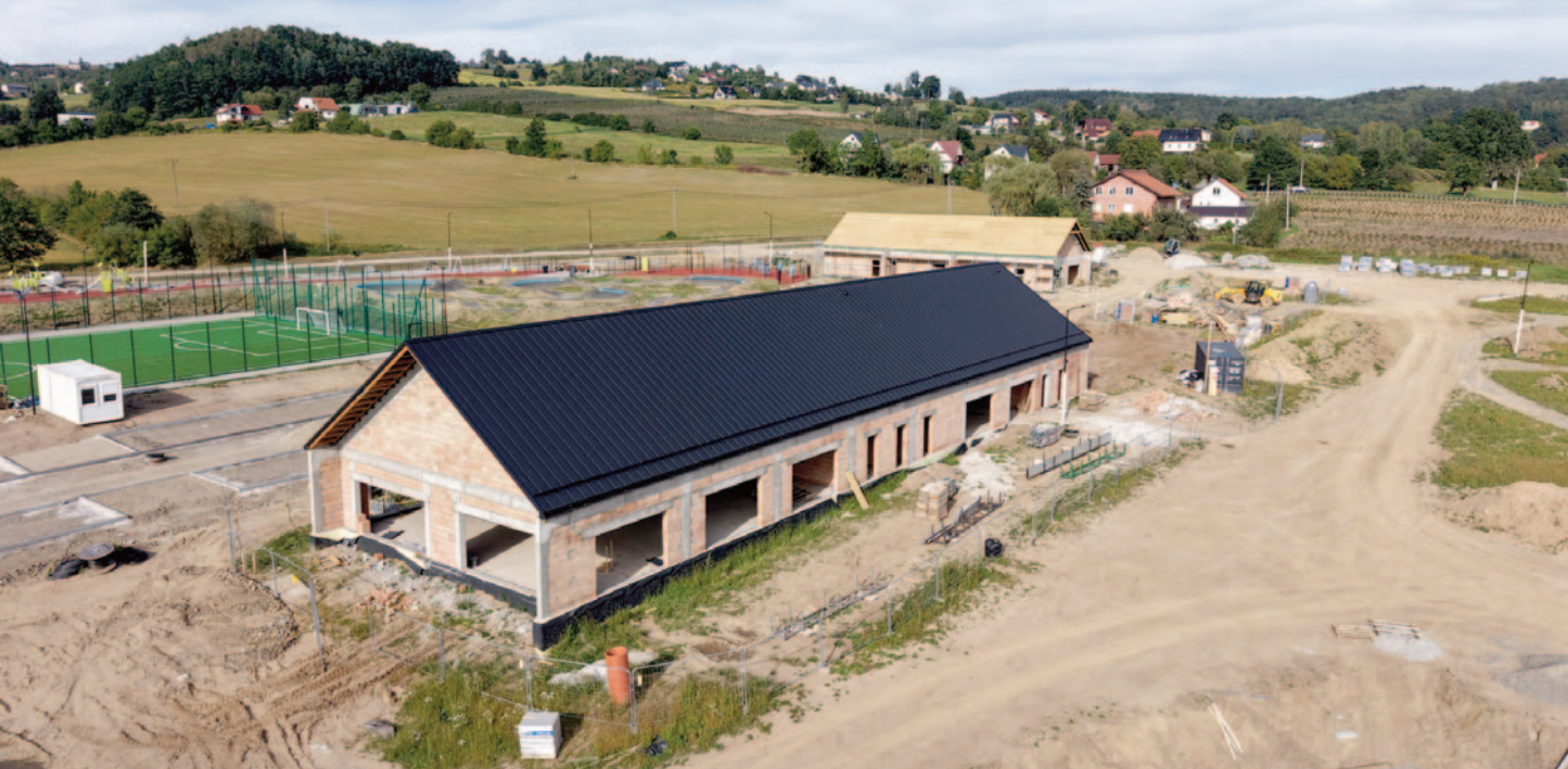
Budowa DDS i świetlicy wiejskiej ma potrwać do końca roku
