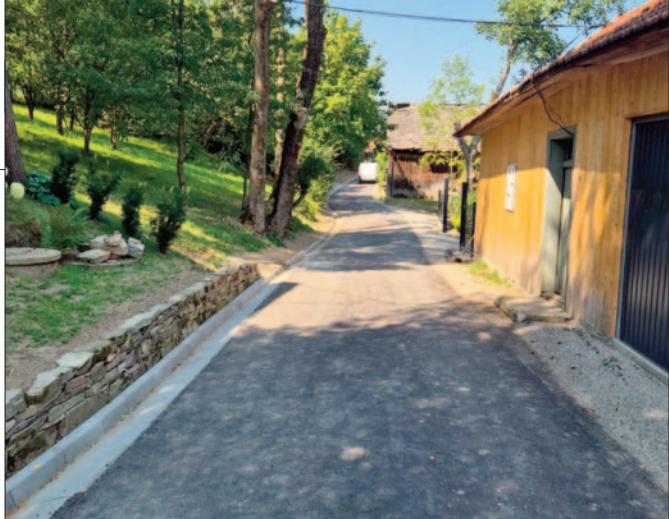
Wyremontowana droga przy kaplicy w Woli Kurowskiej. Koszt inwestycji – 274 020,06 zł
