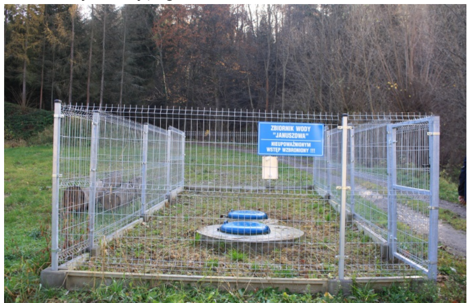
Łącznik wodociągowy gotowy
