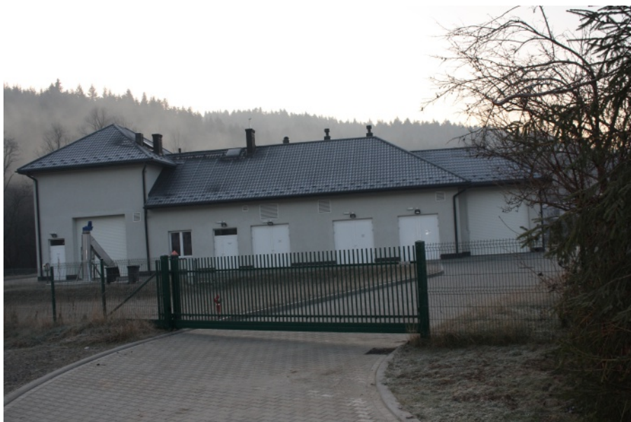
Oczyszczalnia i kanalizacja w Paszynie
