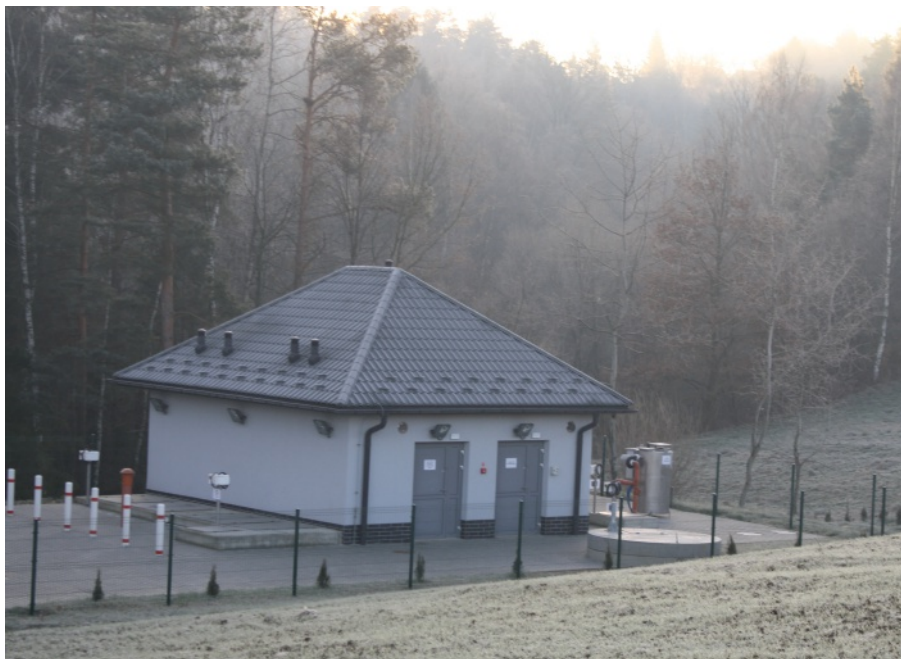
Oczyszczalnia i kanalizacja w Kunowie
