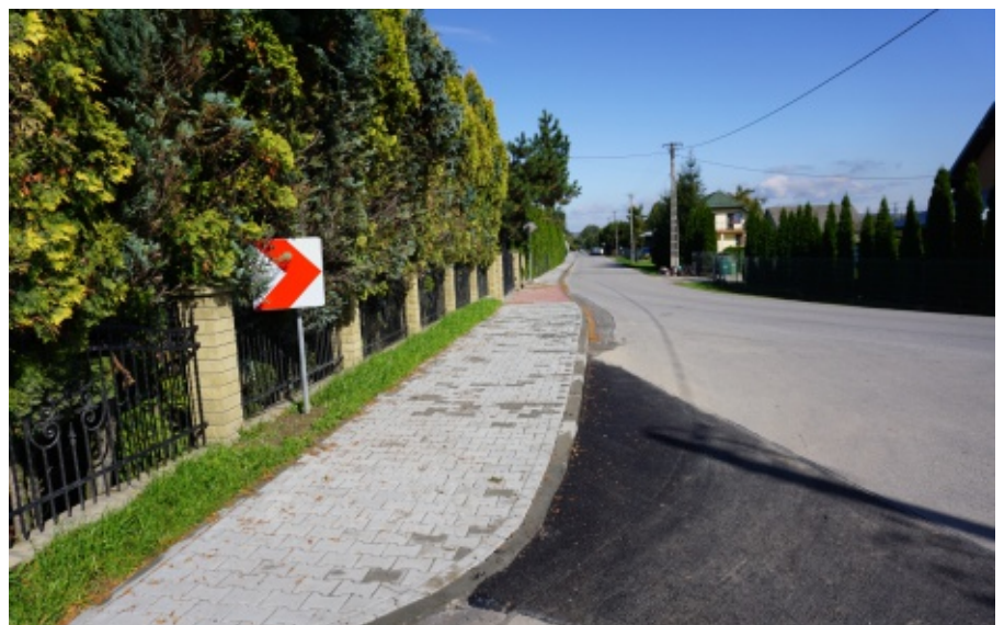
Remont ulicy Gajowej w Chełmcu
