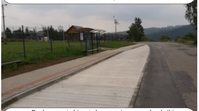
Budowa zatoki autobusowej wraz z chodnikiem przy drodze powiatowej w Kunowie. Wartość całego zadania wyniosła 124 290 zł w tym kwota 62 145 zł pochodziła z budżetu gminy Chelmiec
