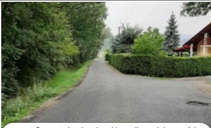
Remont drogi gminnej Łącznik w miejscowości Dąbrowa. Wartość zrealizowanego zadania 103 539,48 zł.
