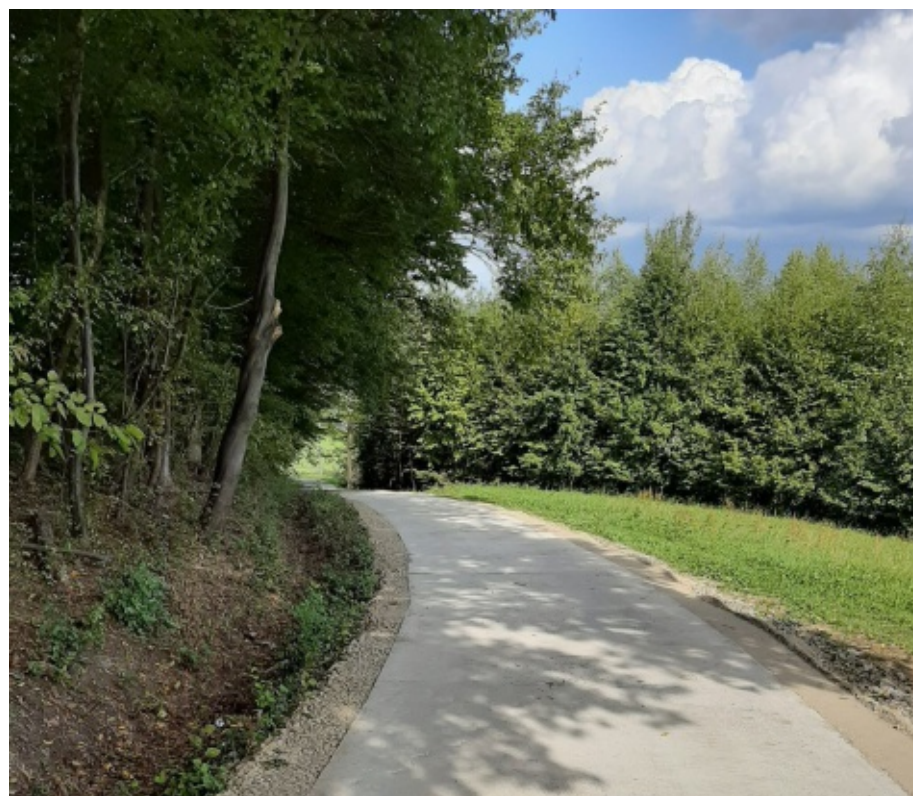
Wyremontowana droga w Paszynie
