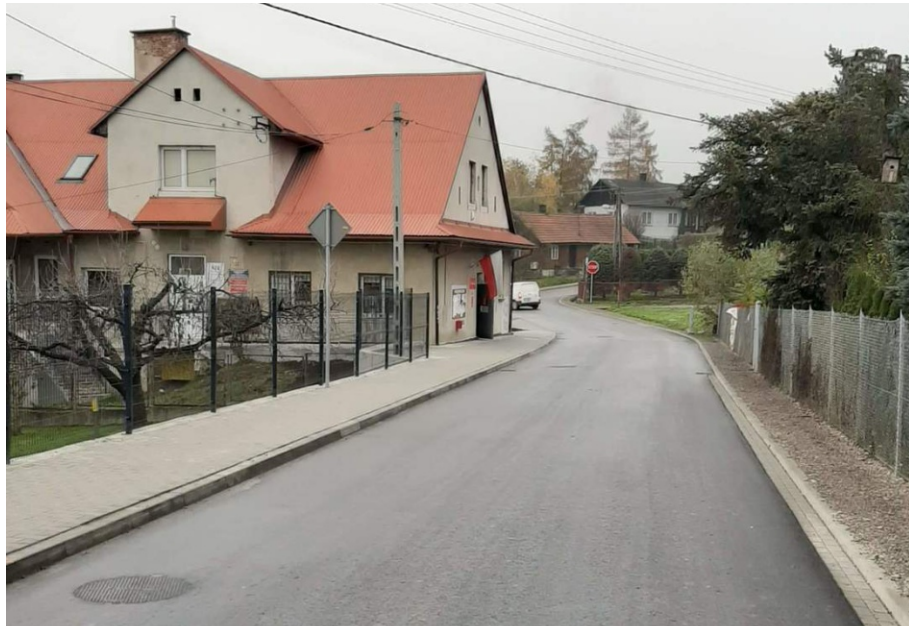
Przebudowa drogi w Wielogłowach
