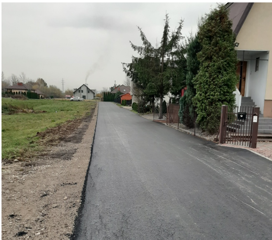
Wyremontowana droga w Świniarsku
