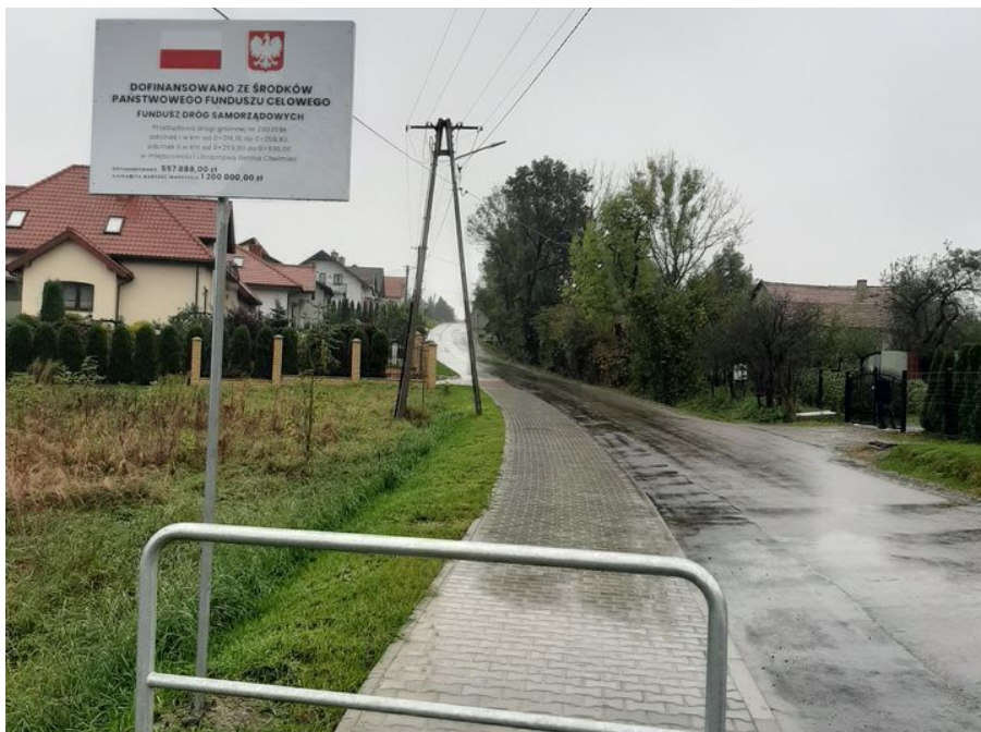
Przebudowa drogi w Librantowej
