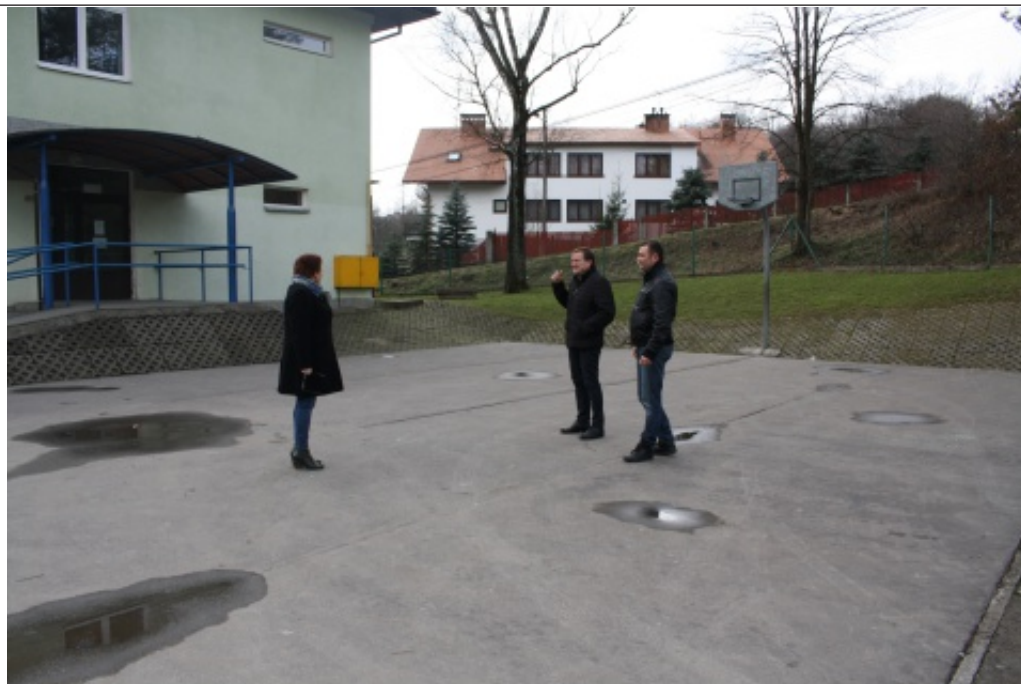
Plac pod budowę przedszkola
