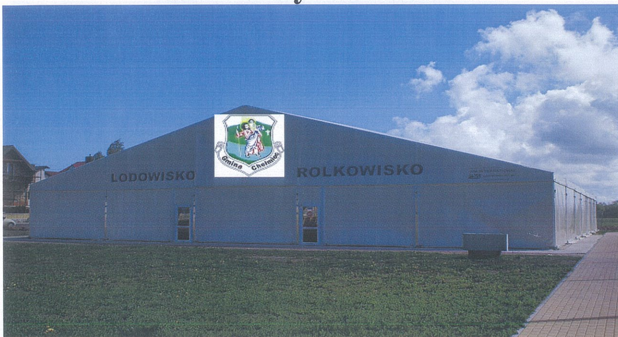
PRZYKŁADOWY FRONT OBIEKTU
