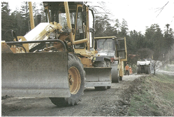
Usuwanie skutków powodzi w infrastrukturze drogowej
