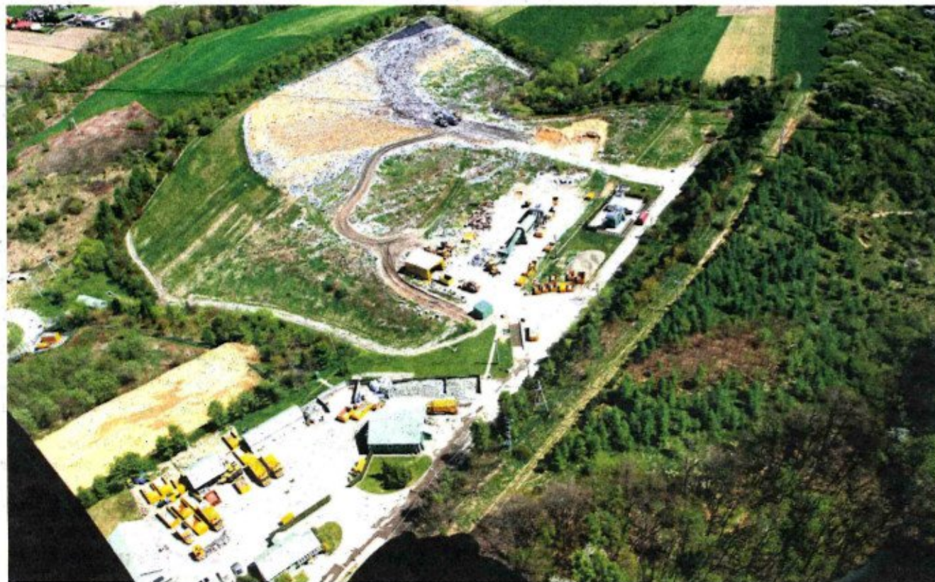
Widok z lotu ptaka na wysypisko odpadów w nowosądeckiej dzielnicy Zabelcze. Tutaj trafiają wszystkie śmieci komunalne z miasta
