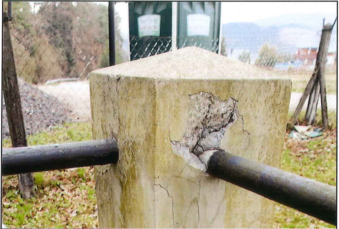
Fot. 18. CMENTARZ Z I WOJNY ŚWIATOWEJ NR 352 W MARCINKOWICACH Fragment uszkodzonego słupka ogrodzenia, stan przed konserwacją. Wrzesień 2022 r.
