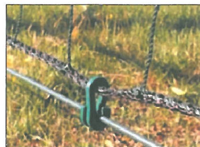
Szczegół łączenia siatki z linką stalową
