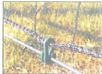
Szczegół łączenia siatki z linką stalową
